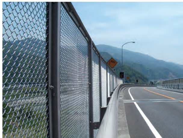
鋼製高欄・落下物防止柵
