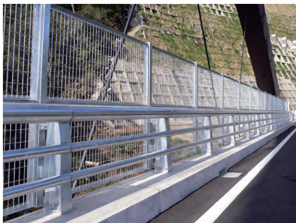
鋼製高欄・落下物防止柵
