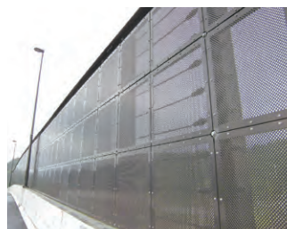
積荷転落防止柵 …10
