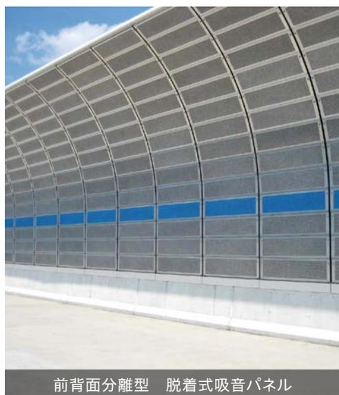
前背面分離型 脱着式吸音パネル
