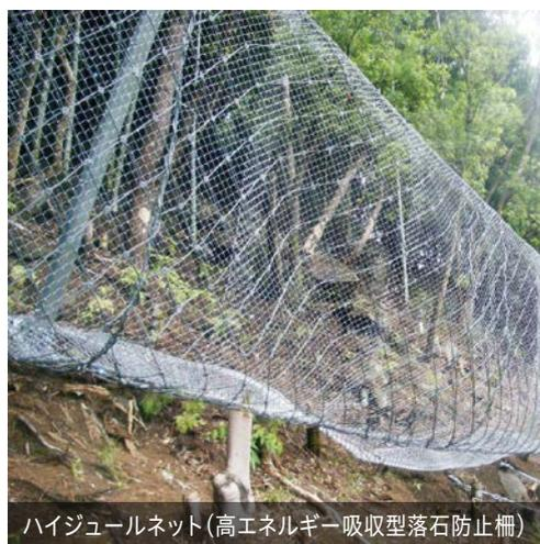
ハイジュールネット(高エネルギー吸収型落石防止柵)
