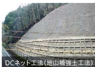
DCネット工法(地山補強土工法)
