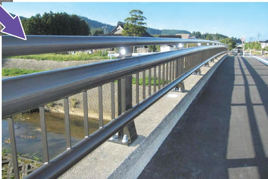
車道側地覆に車両用防護柵設置
